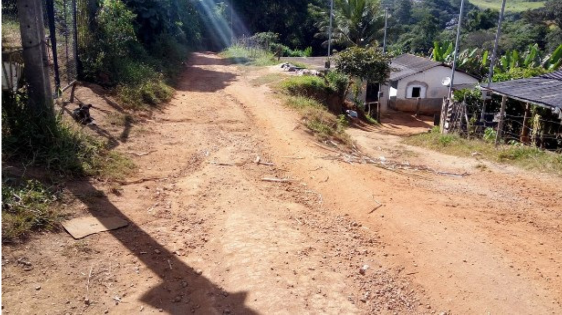
RUA GERALDO FERREIRA DE ARAÚJO
