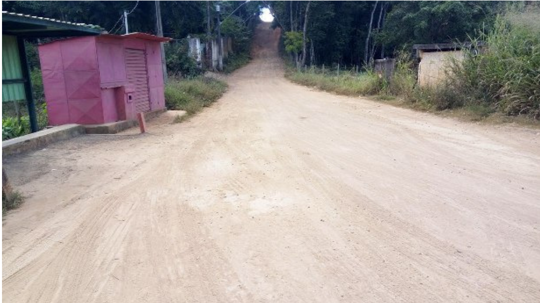
RUA GERALDO FERREIRA DE ARAÚJO
