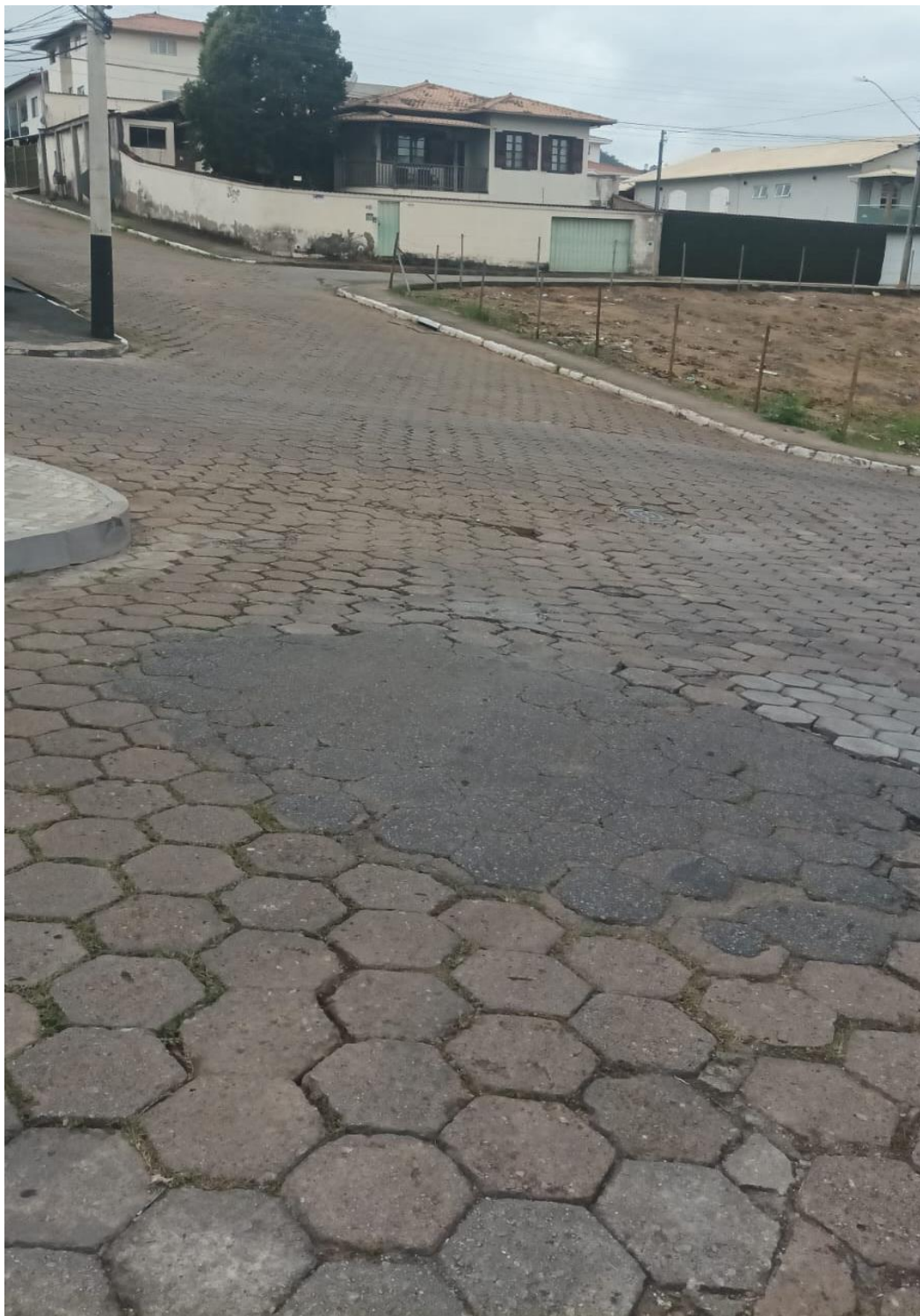
FOTO 4 – RUA PADRE JOSÉ DE ANCHIETA
