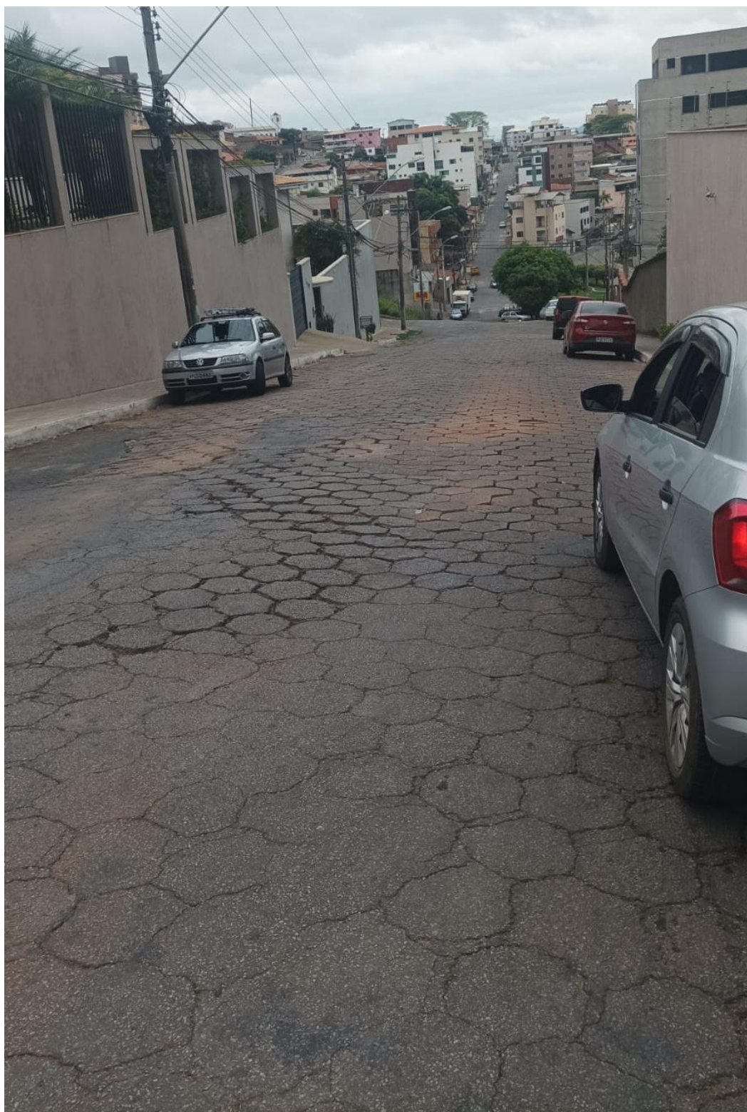
FOTO 10 – RUA PADRE JOSÉ DE ANCHIETA
