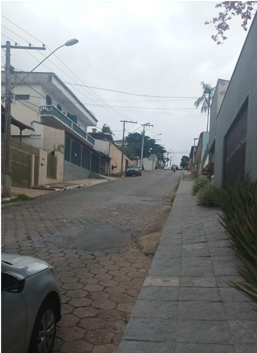
FOTO 3 – RUA PADRE JOSÉ DE ANCHIETA
