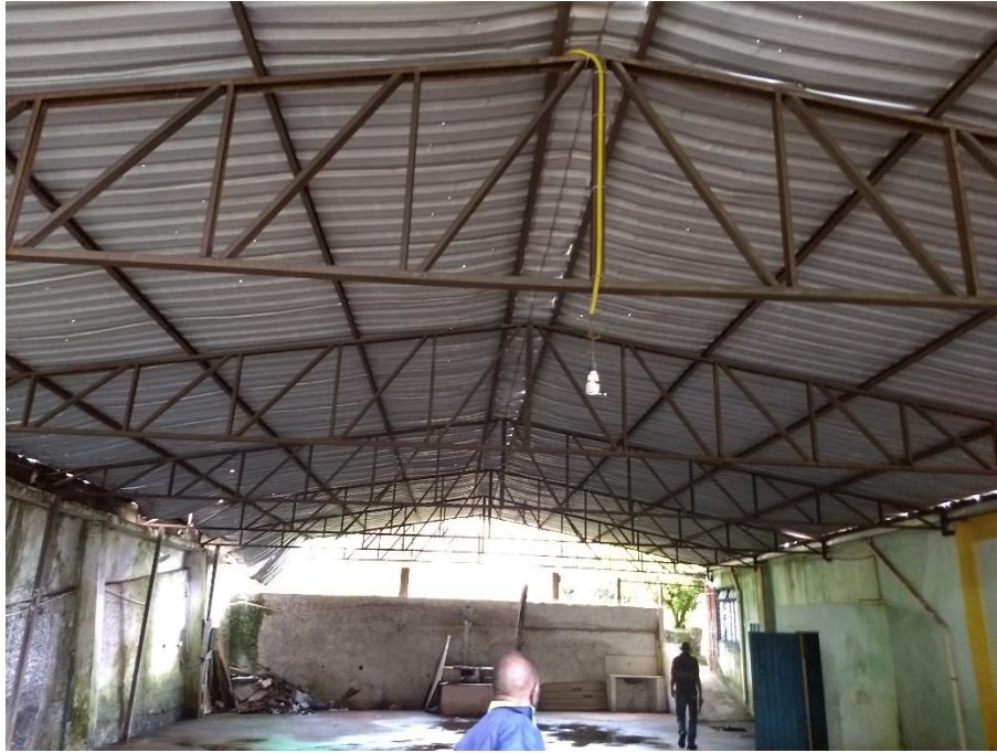
Foto 01 – Estrutura Metálica do Galpão
