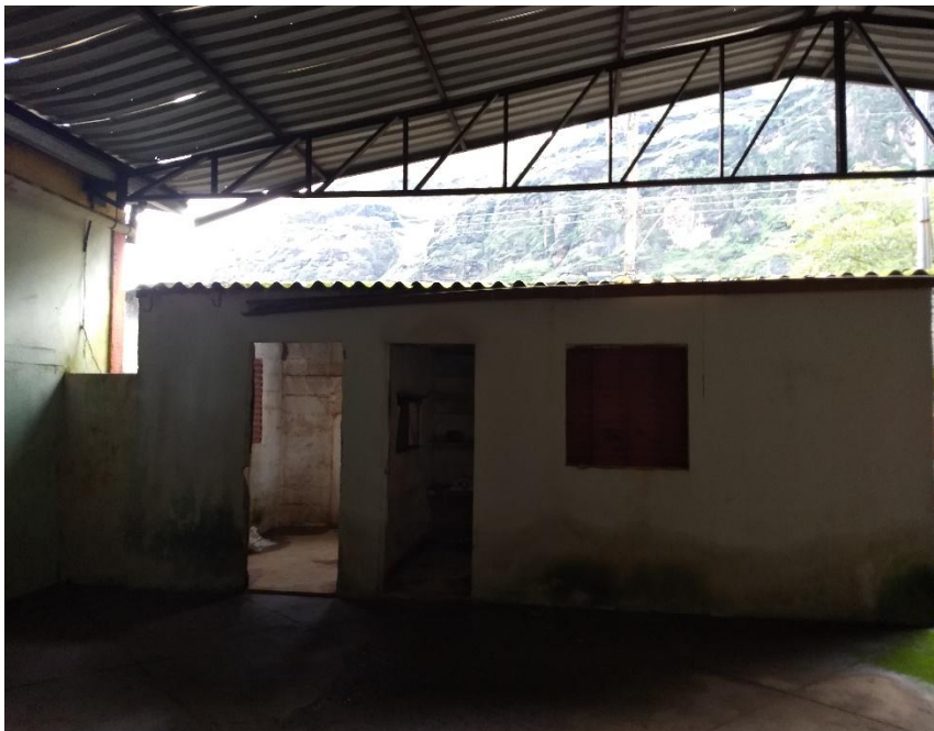
Foto 06 – Banheiros a construir
