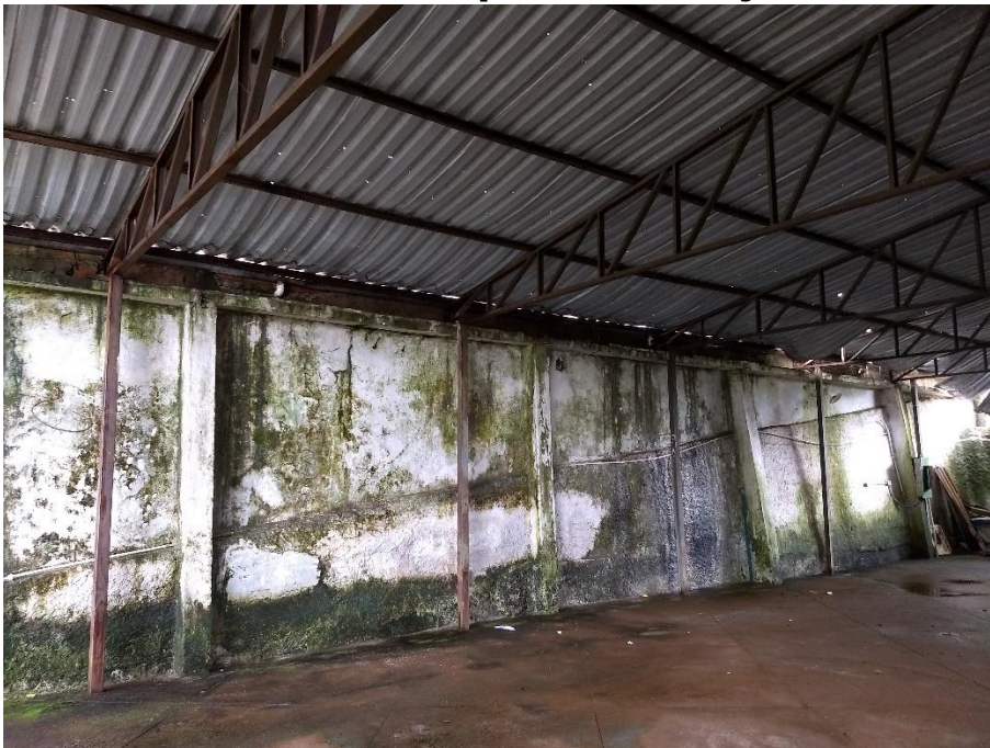
Foto 02 – Muro que será reforçado
