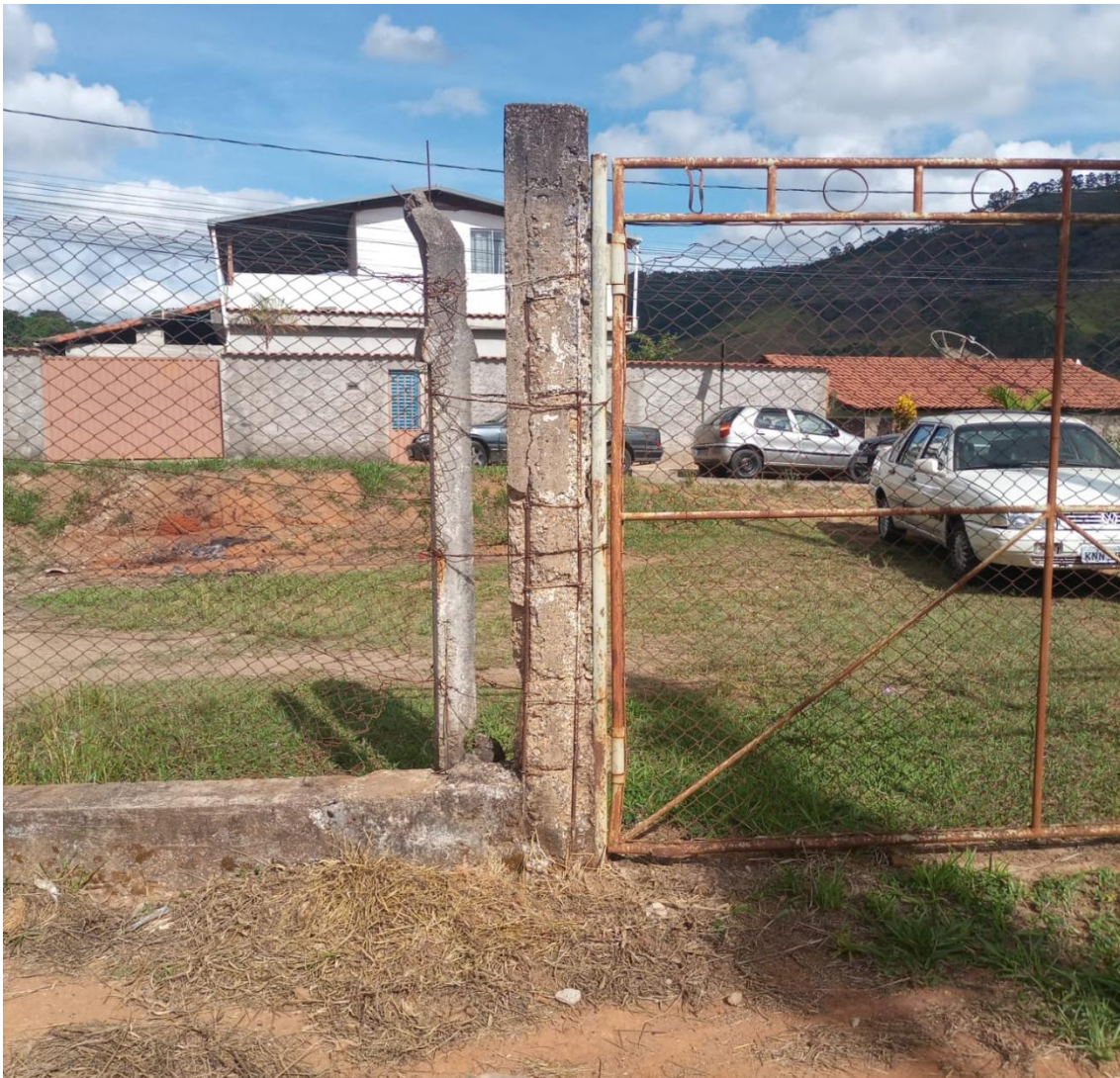
Figura 4 - Pilar de concreto armado.
