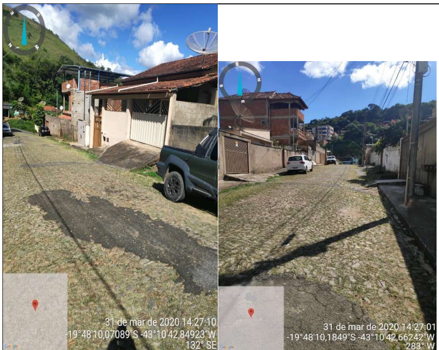
Foto 1 e 2: Tipo de obra: Pavimentação em CBUQ Localização (Bairro e Logradouro): Rosario – Rua Manuel Bandeira
