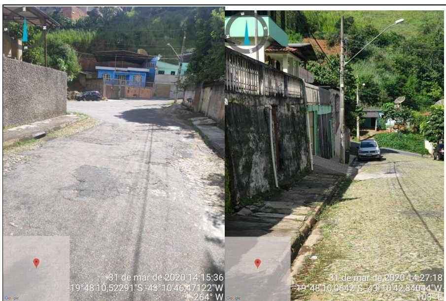
Foto 3 e 4 : Tipo de obra: Pavimentação em CBUQ Localização (Bairro e Logradouro): Rosario – Rua Manuel Bandeira
