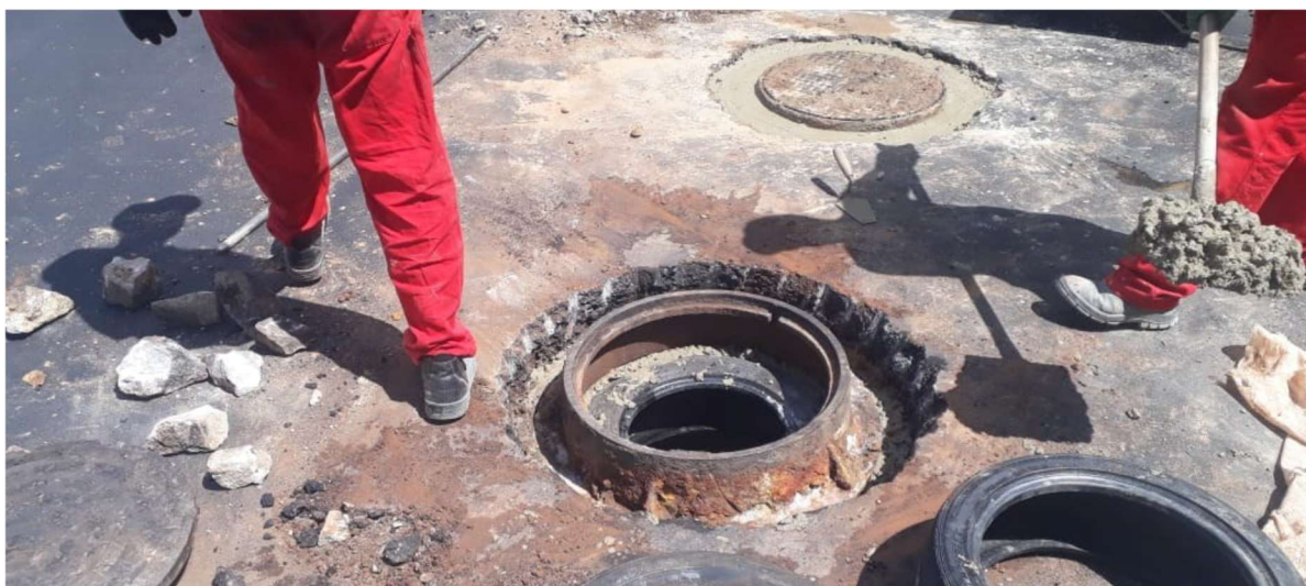
Concretagem da base utilizando pneu como fôrma.
