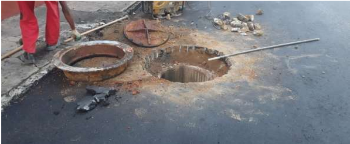
Retirada do aro e tampa do poço de visita para alteamento.
