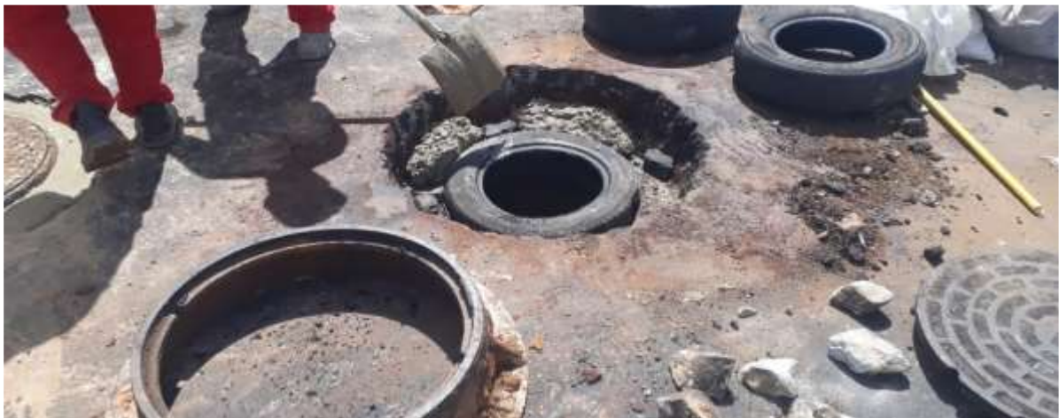
Concretagem da base utilizando pneu como fôrma.
