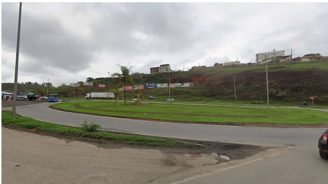
TREVO DA AVENIDA ALBERTO LIMA COM BR-381 – BAIRRO SION
