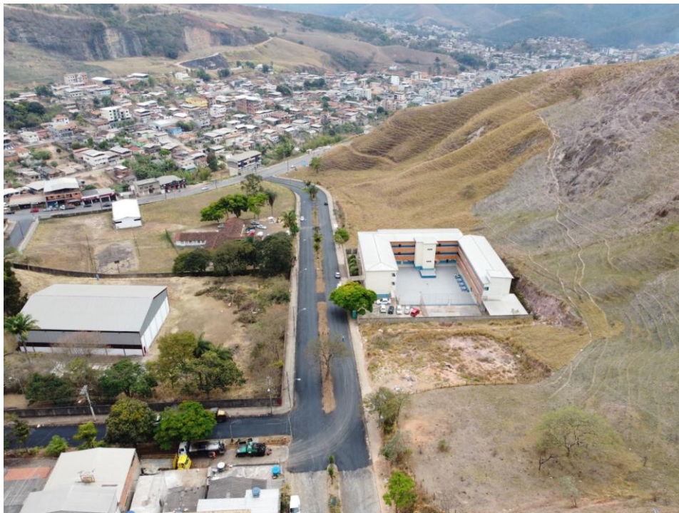
Figura 1 – Logradouro a ser construído.
