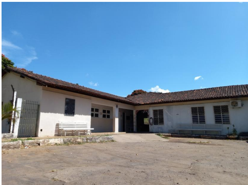
Figura 2 – Logradouro a ser construído.
