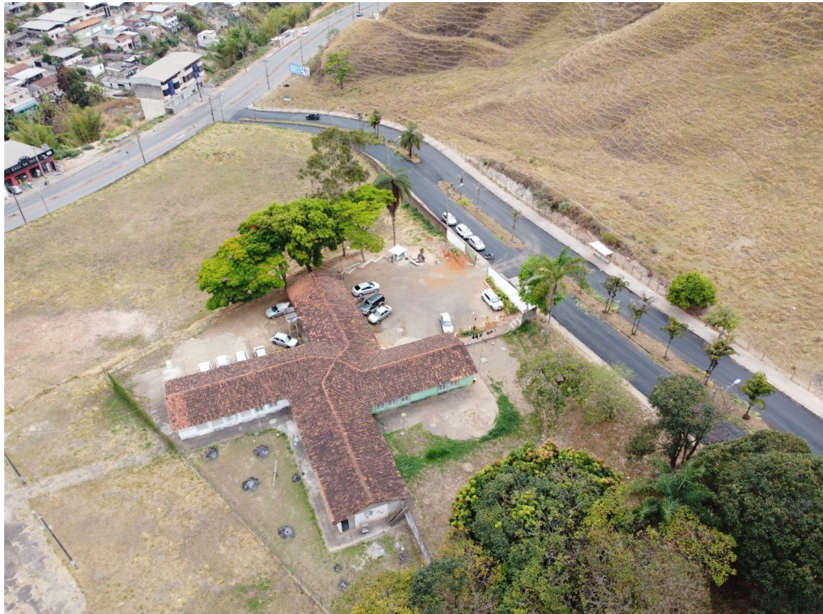
Figura 5 – Logradouro a ser construído.
